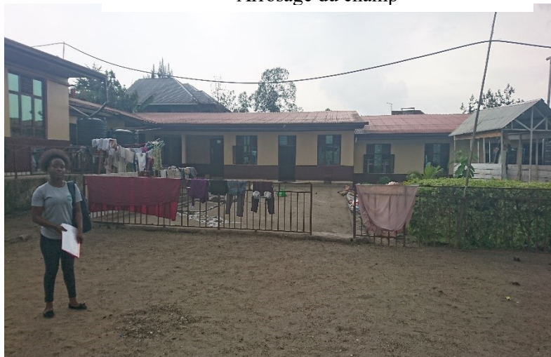
Etude sur la faisabilité du forage de puits d'eau à l'Orphelinat Flamme d'Amour de Kituku par GEMUDI
